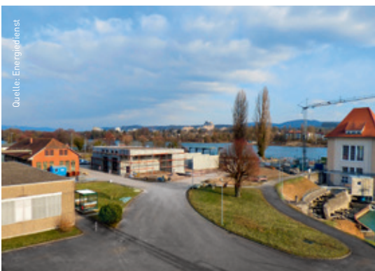
Bauarbeiten an der PtG-Anlage
