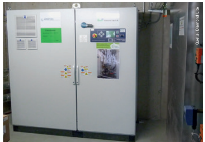
Abb. 2: Der H 2 m-Elektrolyseur erzeugt 2 Nm 3 /h bei 30 bar
