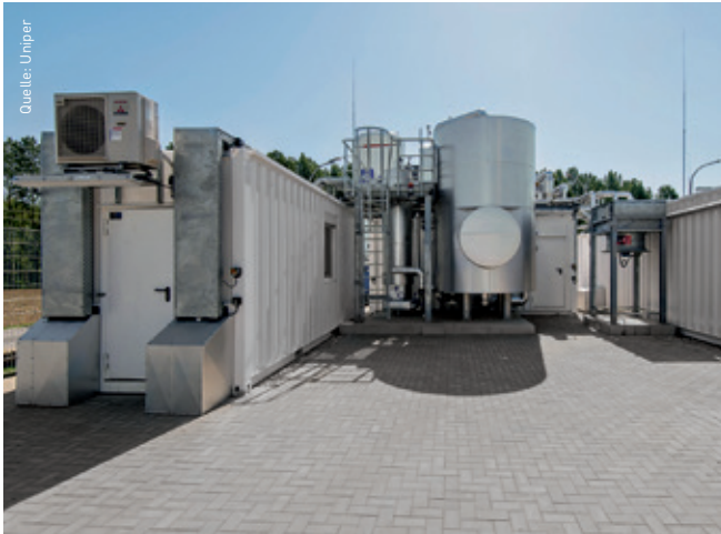
Quelle: Uniper Die in der Methanisierungsanlage entstehende Wärme wird in der benachbarten Furnierfabrik genutzt.
