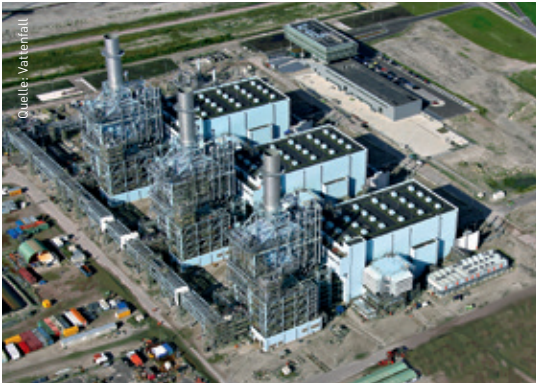
Magnum-Kraftwerk in Eemshaven
