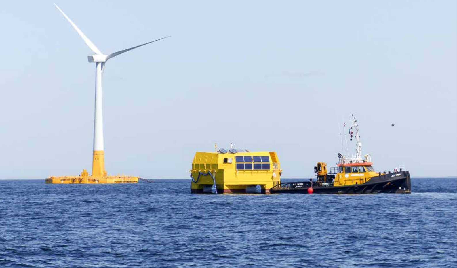
Abb. 1: Versuchsanlage: Schwimmendes Windrad und Forschungsplattform [Quelle: Lhyfe]
