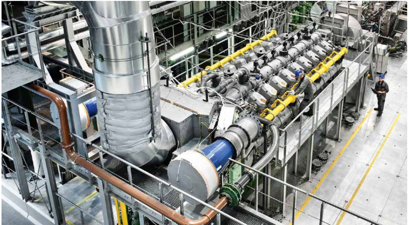
Abb. 1: Solche Großmotoren können heute schon mit bis zu 25 Prozent Wasserstoff betrieben werden [Quelle: MAN]
