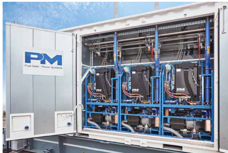
Abb.: Kernkomponenten des HyShelter®-Aggregats [Quelle: Proton Motor]
