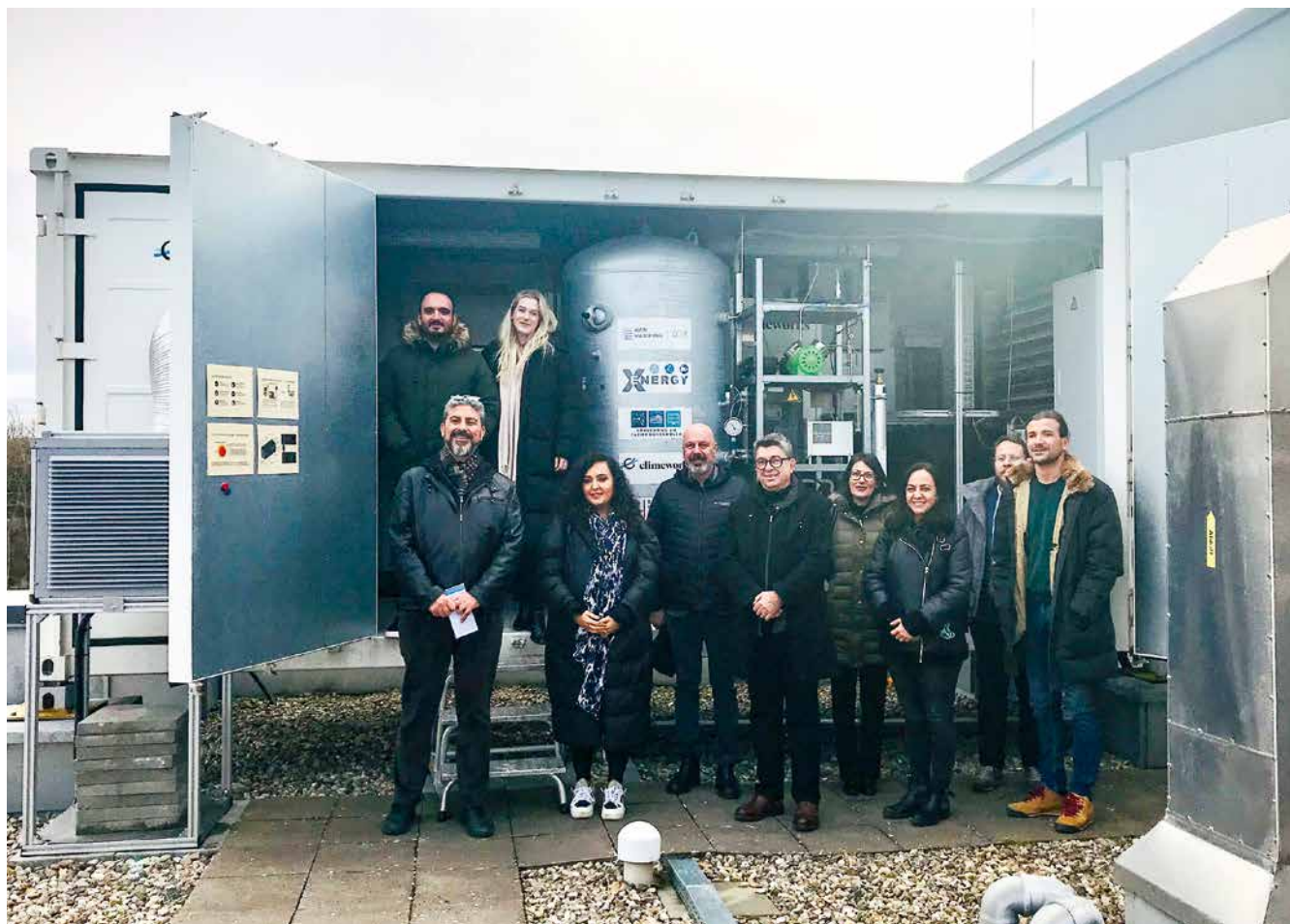
Abb. 1: Fachleute aus Izmir vor der DAC-Anlage im CC4E, Energiecampus Bergedorf [Fotos: Monika Rößiger]
