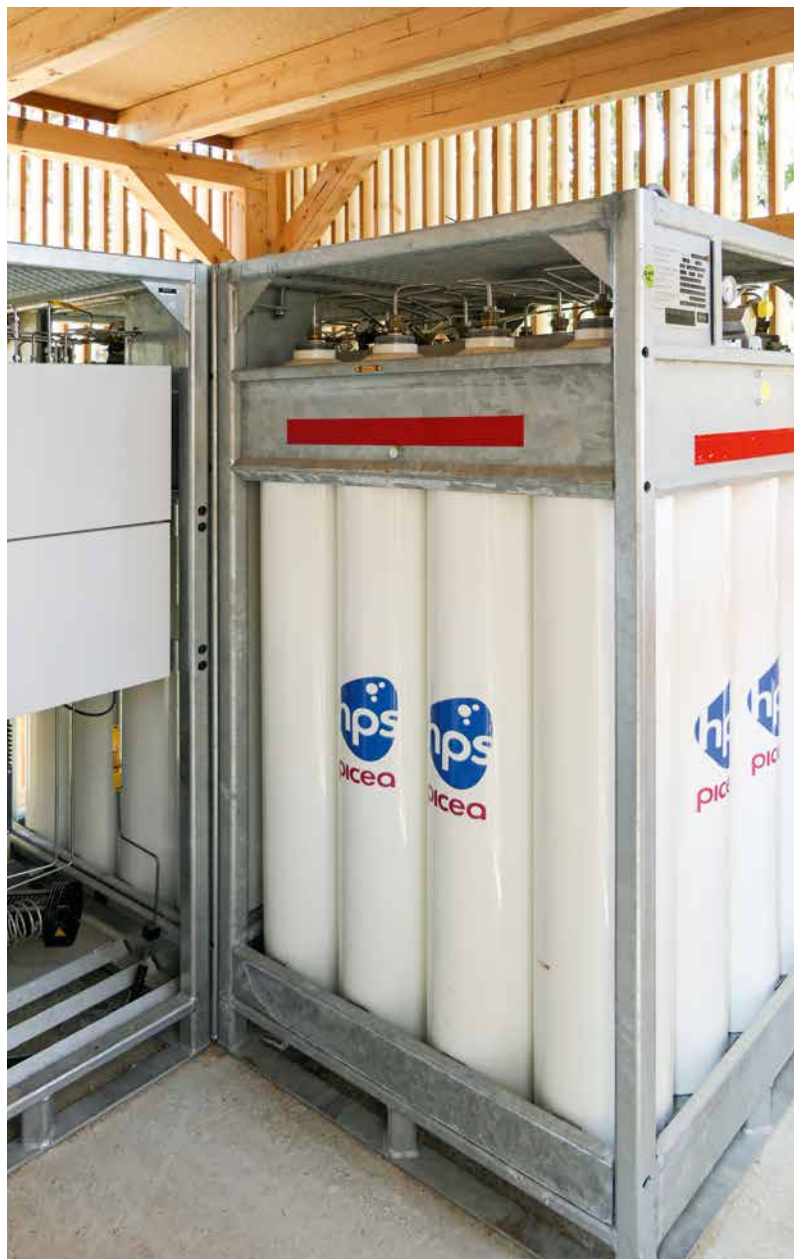
Abb. 3: H 2 -Druckgasbehälter als saisonaler Speicher [Foto: Niels Hendrik Petersen]
