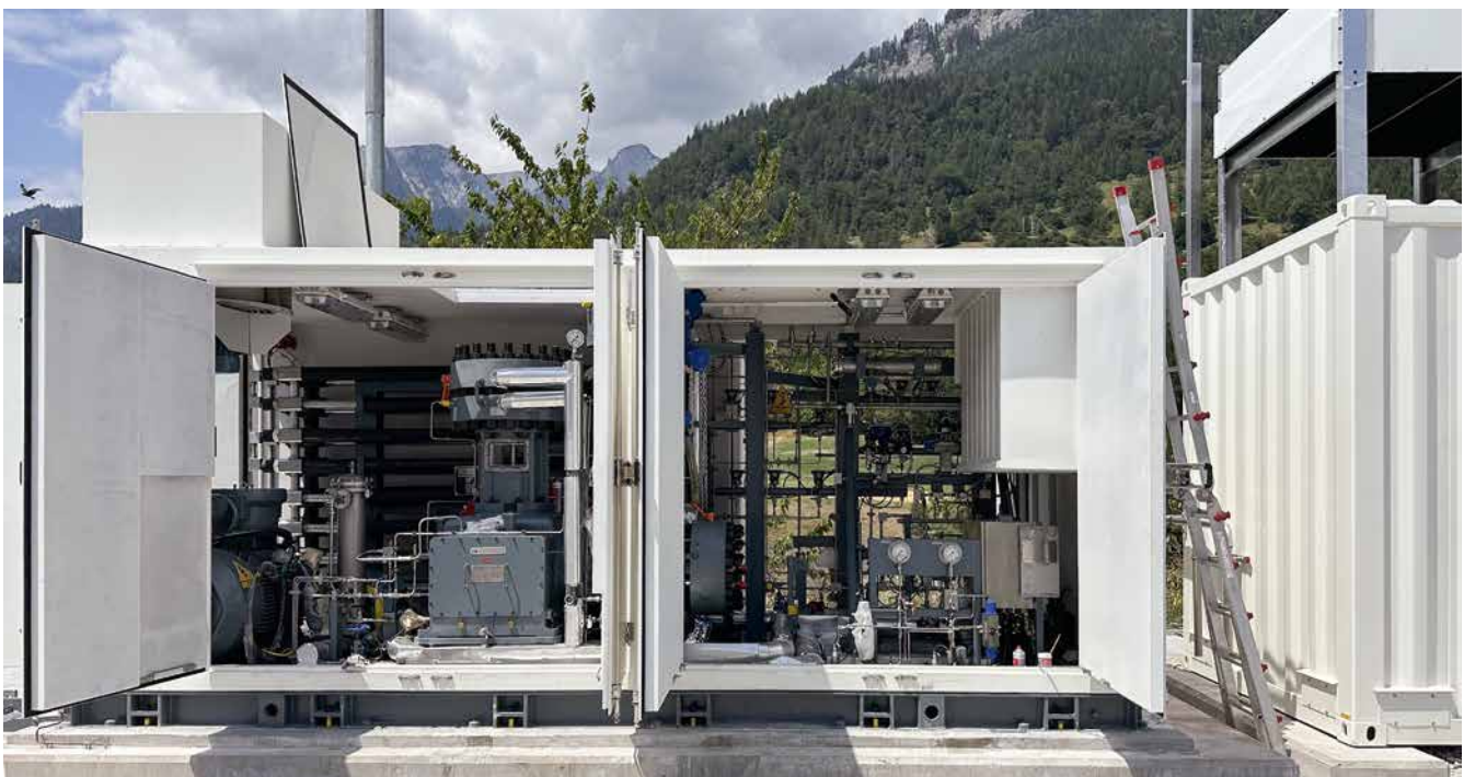
Abb. 2: Die im Bau befindliche H 2 -Anlage [Quelle: Axpo]
