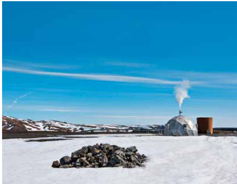
Abb. 1: Bohrloch für Geothermie in Island [Quelle: ON Power, Island]
