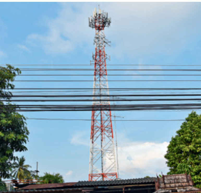
Abb. 2: Telekommunikationsmast in Thailand
