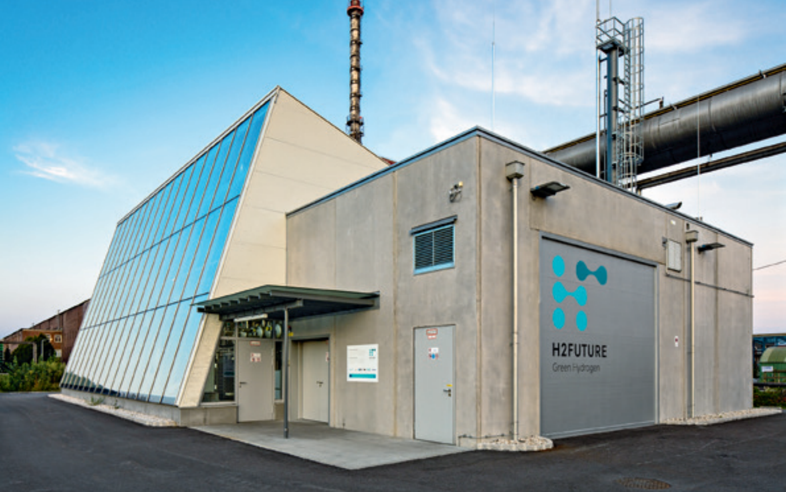
Abb. 1: H2 Future 6-MW-Elektrolyseur in Linz, Österreich [Quelle: FCH JU]
