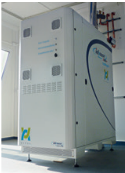
Abb. 1: Erprobung einer dezentralen Energieversorgungseinheit mit Wasserstoff-Brennstoffzelle im Energiepavillon des Chemieparks Bitterfeld-Wolfen [Quelle: inhouse engineering]
