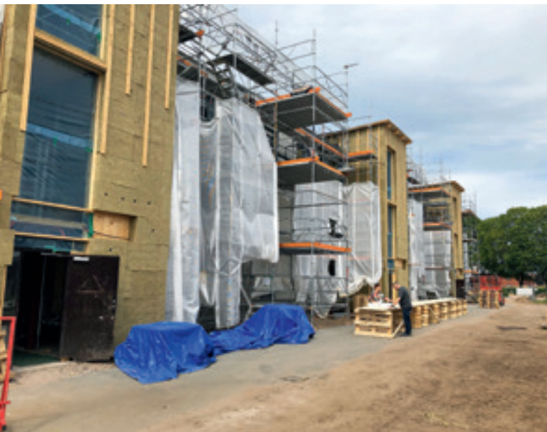
Abb. 1: Die Sanierung und energetische Renovierung der 1975 errichteten Gebäude war ein großes Vorhaben, das die Anbringung neuer hochisolierender Fassaden und die Installation des einzigartigen netzfernen Energiesystems auf Basis von Solarstrom und saisonaler Wasserstoffspeicherung umfasste – während (links) und nach (rechts) der Sanierung. [Source: Vårgårda Bostäder]
